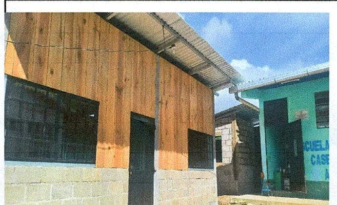
Foto 2: PUERTA METALICA INSTALADA
