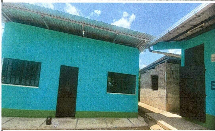
Foto 1: MEJORAMIENTO DE AULA Y COCINA TIPO PORTICO TERMINADO
